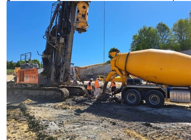
In diese Bohrung werden die Bewehrung und danach der Beton eingebracht. In der Summe bilden später 315 Großbohrpfähle das Fundament für das Kombibad.
