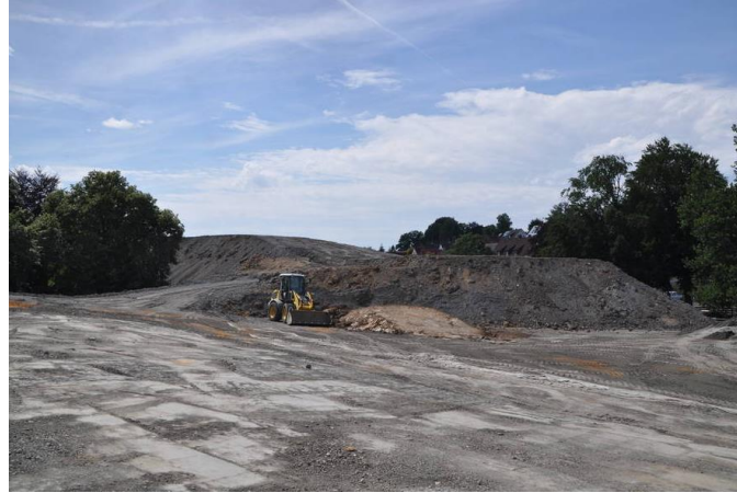
... in sehr imposanten Haufwerken bis zu einer Höhe von 15 m aufgeschüttet und verdichtet hat.
