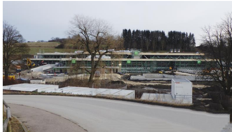
Blick auf die Nordfassade. Die Außenbecken sind erstellt. Die Attikaunter-Konstruktion für die Blenden bereits angebracht. Die Glasfassade ist fertig.
