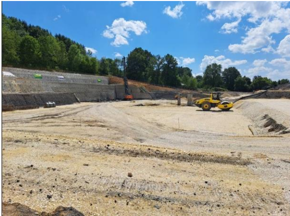
Nachdem die Firma Stark mehr als über 41.000 m 3 Erde bewegt und...
