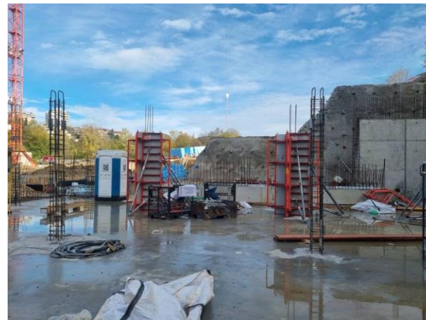
Sobald alle Träger einen Pfahlkopf betonierte bekommen haben, konnte der nächste Schritt, die Herstellung der Bodenplatten erfolgen.
