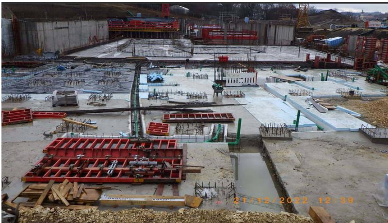
und angespitzt, sodass dann in einem nächsten Schritt die Pfahlköpfe hergestellt werden können.
