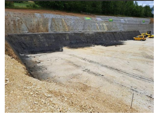
Wurden auf Grund der schwierigen Hangverhältnisse zur Baugrubensicherung zwei Verbaumaßnahmen mittels Spritzbetonwänden erstellt.
