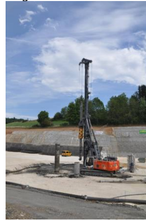
und auf einer Bohrpfahlgründung gegründet. Hierzu werden Bohrungen (durch die nicht tragfähigen Bodenschichten) bis in den tragfähigen Bereich abgeteuft.
