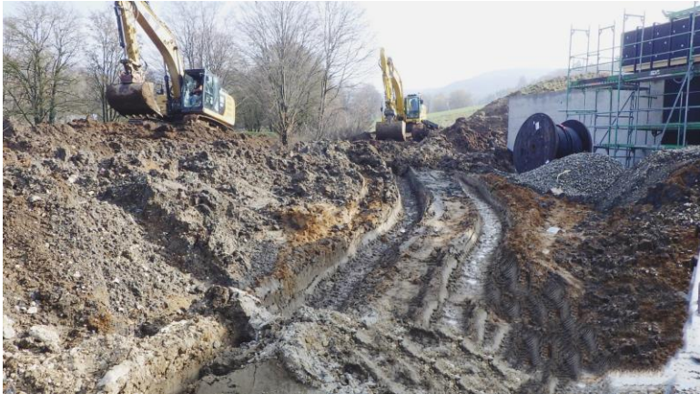
Blick das Gelände und auf die südöstliche Stützmauer neben dem Verwaltungstrakt
