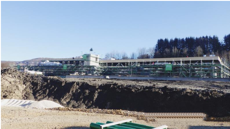
Ansicht West. Das 50 m-Schwimmerbecken ragt nur noch zu einem kleinen Teil aus dem angeschütteten Erdboden heraus und gibt eine Vorschau auf das zukünftige Gelände. Millerweile sind alle Becken durch Zeltgerüste v Verdeckt.
