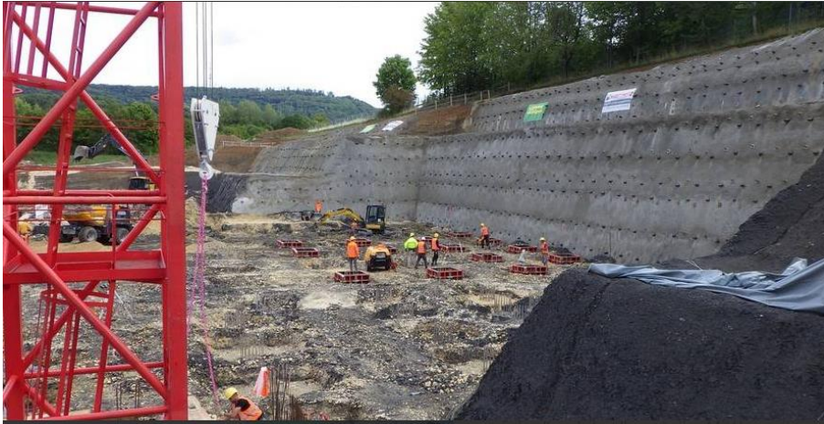
Die 315 Bohrpfähle sind betonierte und fertiggestellt. Das Aushubmaterial aus den Bohrpfahlgründungen wurde abgefahren.
